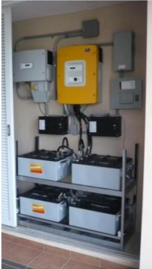
En un banco las baterías se conectan en **serie** y en **paralelo** para obtener un *voltaje* y una capacidad en *amperios-hora* deseados.
